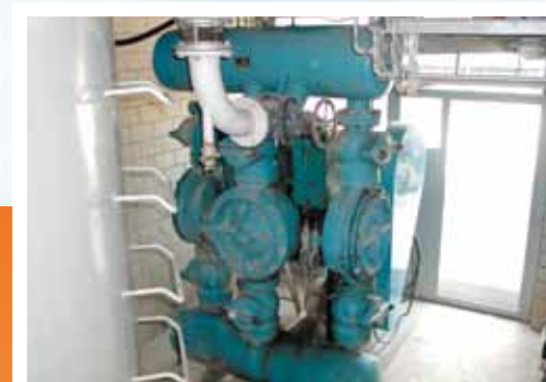
bomba de alimentación de alta presión
